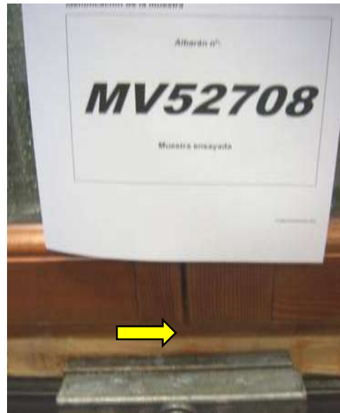
Zona de filtración de agua
